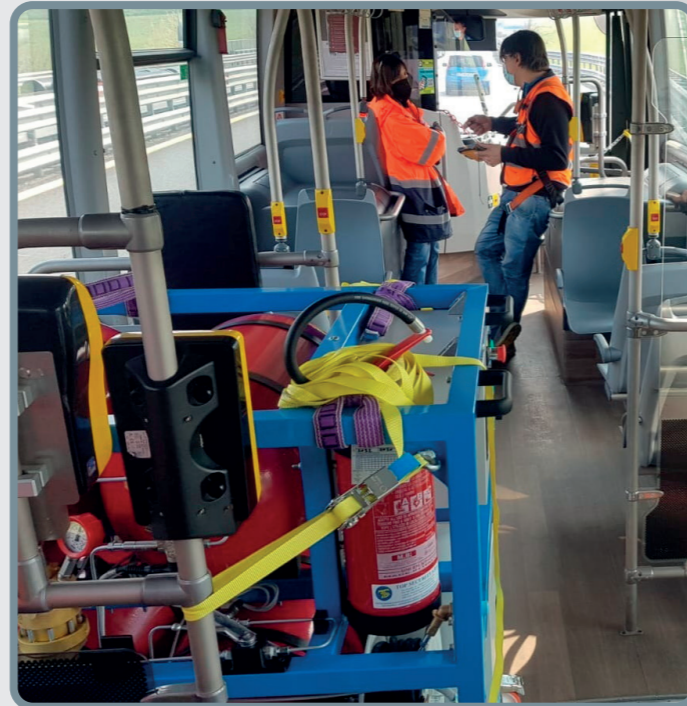
Installazione su bus SCANIA
